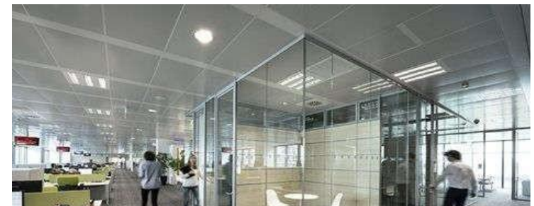
Controsoffitto modulare con corpi illuminati led ad incasso
