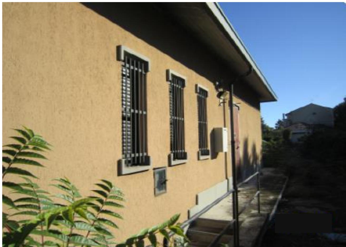
*Due fabbricati (uffici e cabina) presentano una struttura in muratura, le facciate sono intonacate e tinteggiate. Il terzo fabbricato corrispondente al capannone è costituito invece da una struttura portante in c.a.p. e copertura a falde inclinate.
